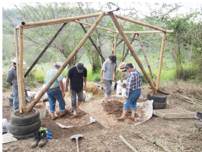
préparation des mezclas de terre
