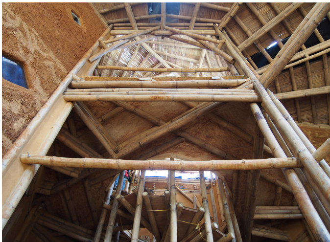
l'escalier central en spirale
