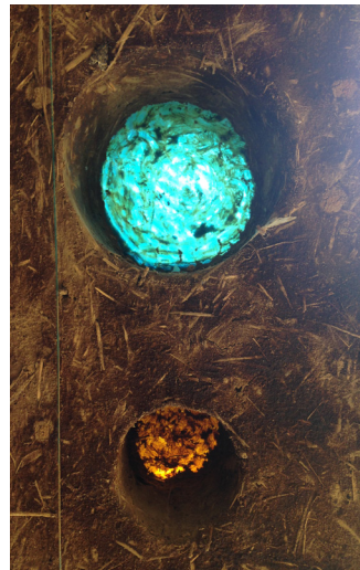
utilisation de morceaux de vitraux dans le remplissage en terre
