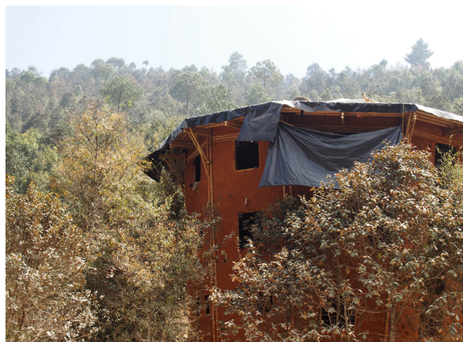
trois étages de structure en bambou et remplissage en terre
