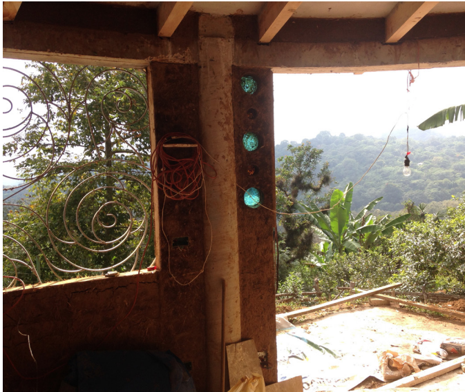
utilisation de morceaux de vitraux dans le remplissage en terre
